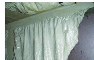
塗膜を湿潤化させることで塗膜粉塵の飛散・拡散を低減
