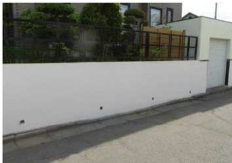
コンクリート製擁壁
